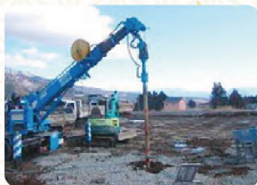
最新の地盤調査と 地盤改良工事
