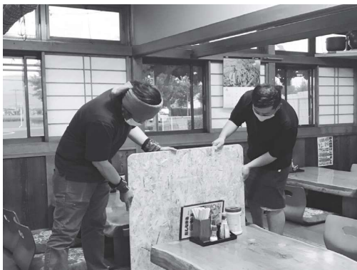
昭和町：パーティション設置
