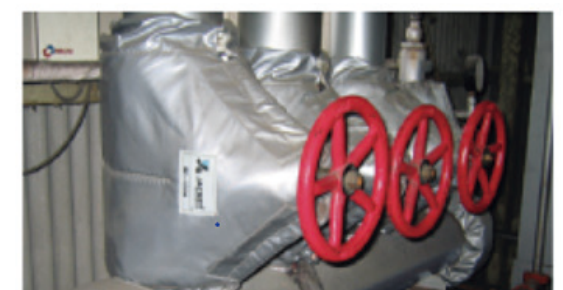
保温カバーを取り付けた 蒸気バルブ
